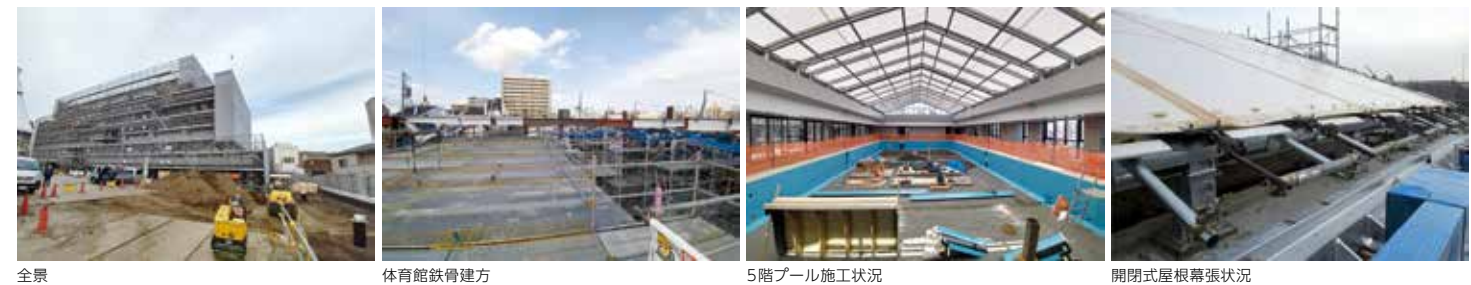
全景 体育館鉄骨建方 5階プール施工状況 開閉式屋根幕張状況
