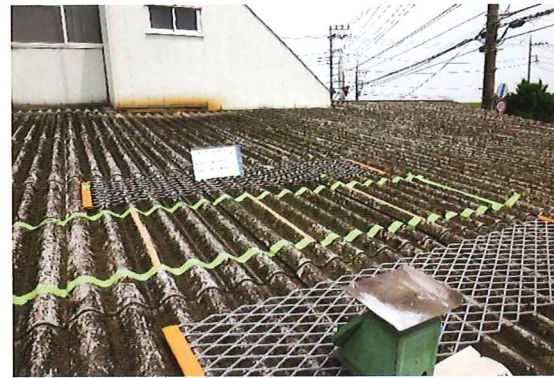
踏み抜き防止足場（メッシュロード）使用 ピーリング試験
