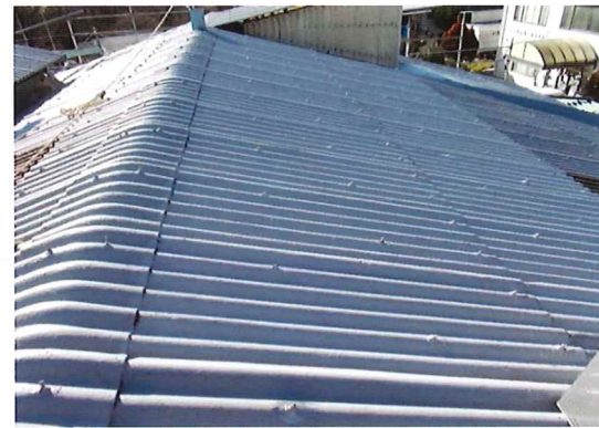
バッファークート施工例
