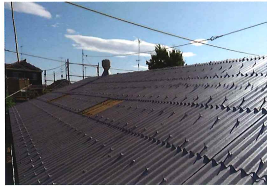
バッファークート施工例
